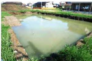
調査区水没状況 (南東から)
