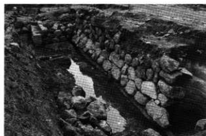
水路石垣(西侧)
