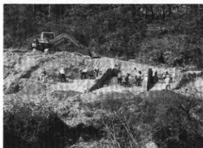
4・5テラス作業風景
