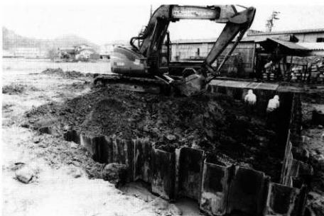
2.表土掘削状況 (南より)
