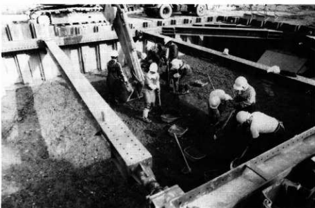
3.表土掘削状況 (南より)
