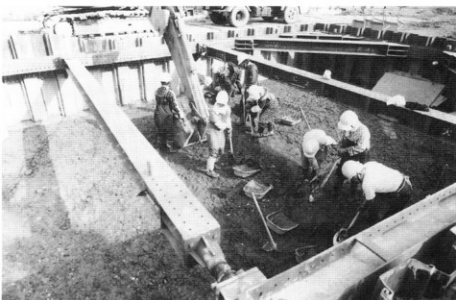
3.表土掘削状況（南より）
