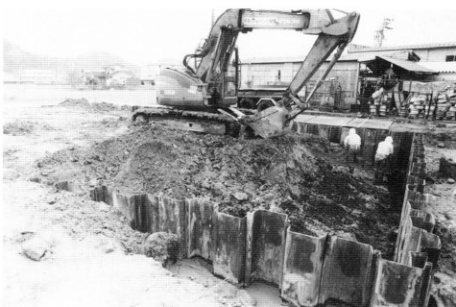
2.表土掘削状況（南より）
