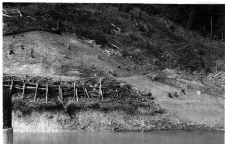
2区・3区全景 (北から)
