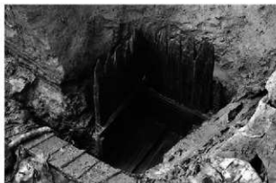
S E 106 横桟組方 (北東から)
