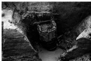
S E 324 (東から)
