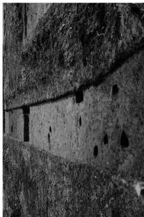
E-II地区 (西から)
