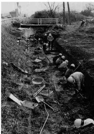
D地区作業風景
