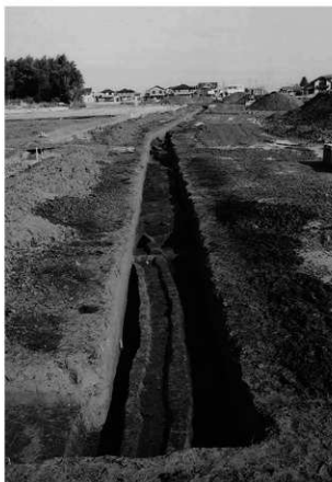
B-II地区南部（SD345より北）（南から）
