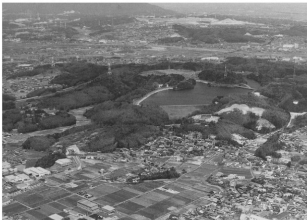
工事前遠景（南東から）
