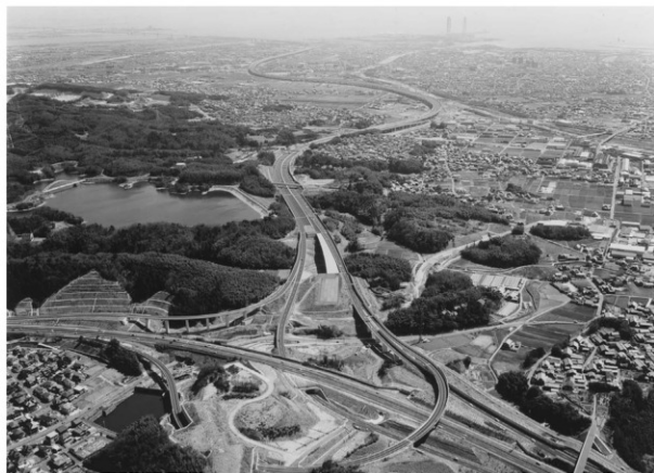
工事後遠景（西から）
