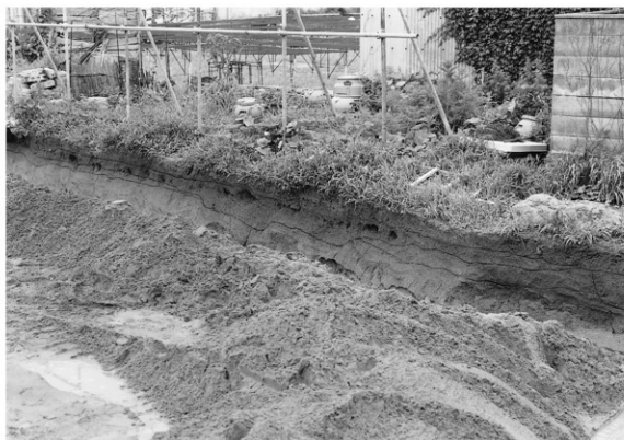
調査区東部北面土層(東南から)
