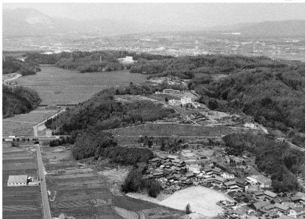
工事着工前全景
