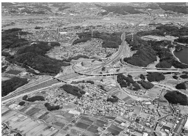
工事完成後全景
