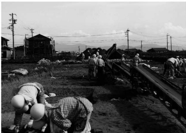
作業風景（北西から）
