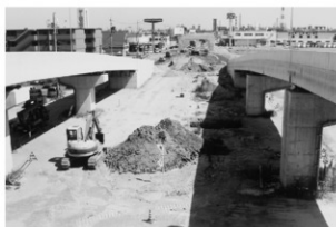
CP1 トレンチ掘削前状況
