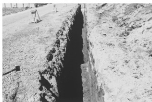
No. 4 トレンチ完掘状況
