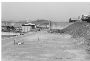
No. 4 トレンチ掘削前風景
