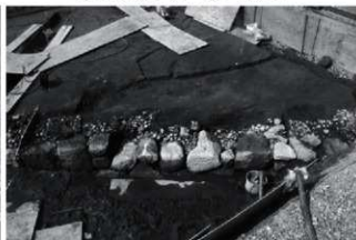
崩落ぐり石除去後（東側）南から
