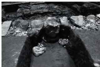
石垣背面の様子② 北から
