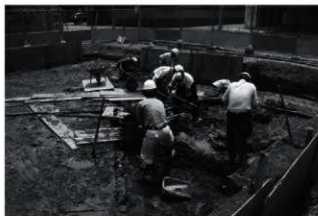
堀掘削作業 北西から
