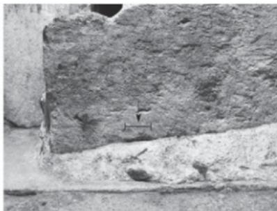
図II-55 南壁石下面下辺の樋子穴（南から）
