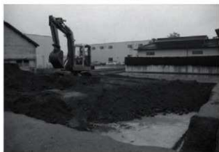
埋め戻し作業
