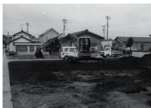
埋め戻し作業
