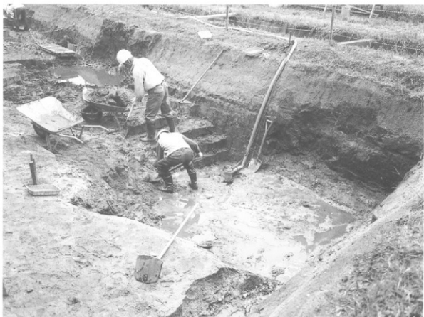
S R 2 掘削作業風景
