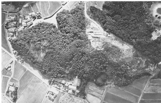
第1次調査区遠景（北から）
