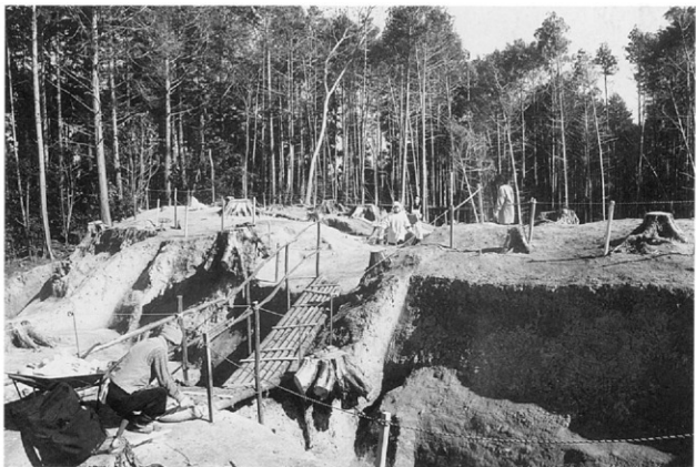
作業風景 4 (現地説明会準備)
