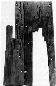
写真7 縦壁板の接合(1249と1250)
