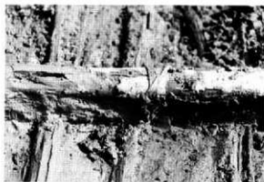
写真8 壁木舞縦材と横材の繋ぎ
