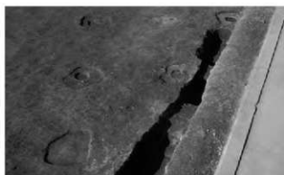
5-掘立 1 (南東から)
