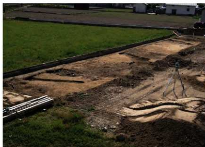
第30調査区 全景（北東から）
