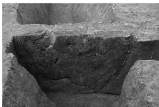
11-SD 8 a 断面 (北西から)
