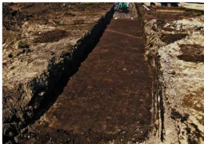
第 40 調査区 全景（南東から）
