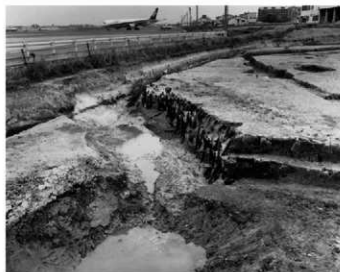
(1) SD0065 東岸杭 (3) (南東から)
