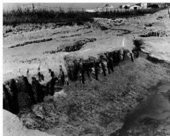
(1) SD0065 3・4 区西岸杭 (2) (南東から)
