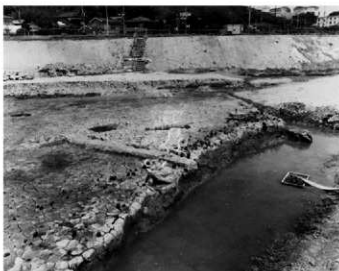
(6) 3面北半畦検出状況 (西から)
