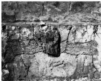
(5) SP0047 柱 (西から)
