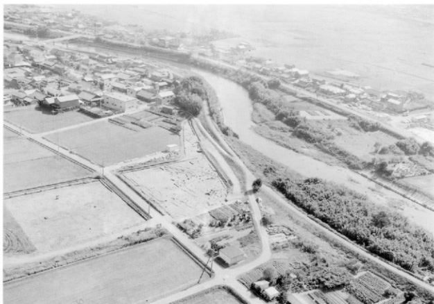
調査区遠景（西から）
