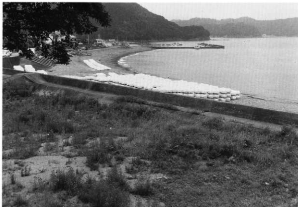
調査前風景(南西から)
