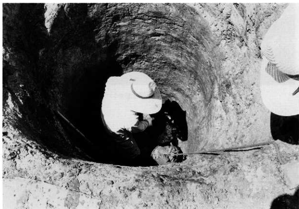
SE3 掘削作業（北から）
