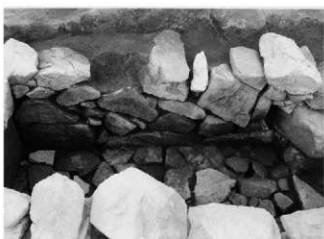
図版Ⅵ-26 玄室右側壁(北から)
