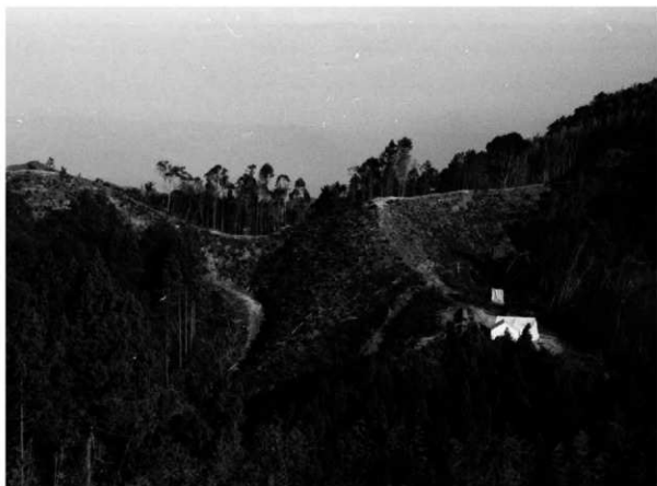
図版V-1 38次調査遠景(北西から)
