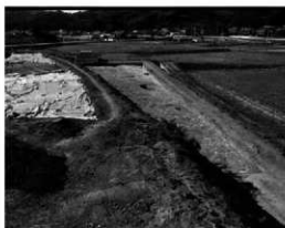
図版Ⅳ-15 4. E区全景（南東から）
