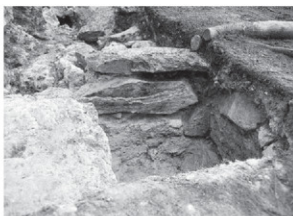
写真3-84 5トレンチ配石列と下部盛土 西から(7次)
