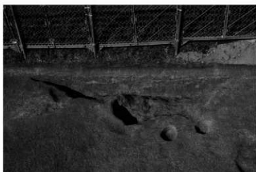
4) SK-06掘削状況 (南東から)
