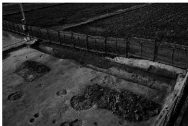
6) 北壁断割り状況 (南東から)
