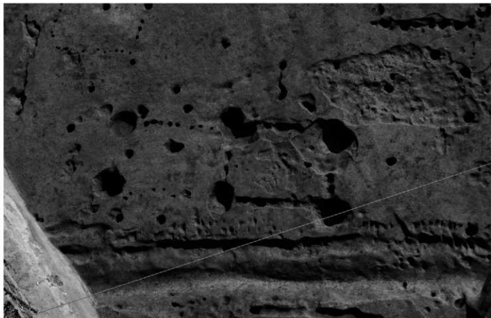
1) SB-01完掘状況 (北西から)
