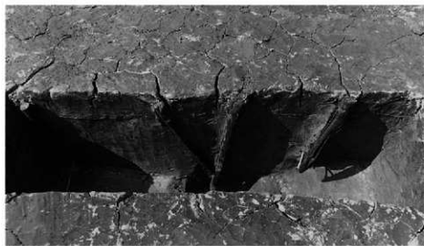
(2) SX1246 杭列断面 (南から)
