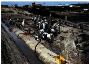
第Ⅱ面 SD735 掘削風景
