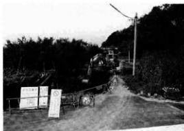
写真2 A区重機による表土剥ぎ
