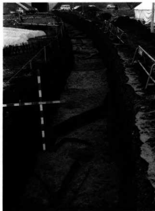
写真15 C区全景 (南から)
