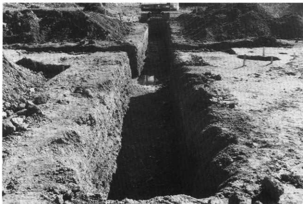
下層調査トレンチ (西から)
