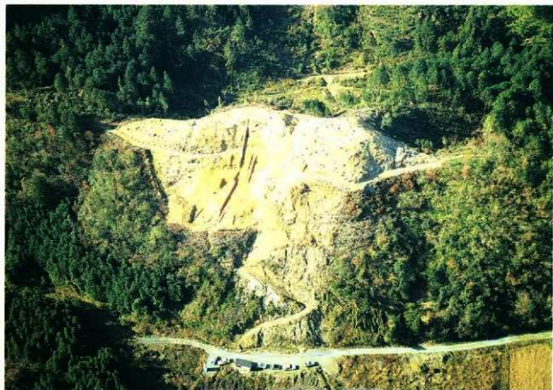
山神城跡ベト谷地区（東上空から）
