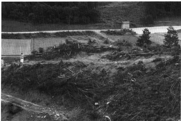
調査前風景（北から）
