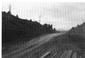
図12 工事中の近畿自動車伊勢線における黒色片岩の露頭・玉城町勝田南方(1991年12月撮影)
