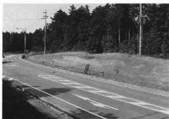
photo. 2 A地地点遠景(南から)
