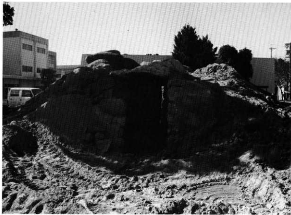
姫野町立姫野中学校校庭へ移築中の1号墳石室
