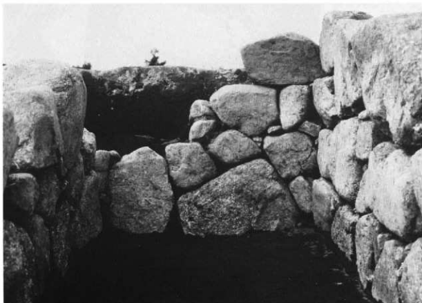
6号墳石室（南東から）
