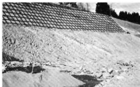
図4. 松尾層、總野サービスエリア造成地(90.1.2)
