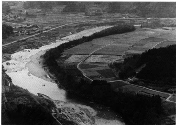
調査後遠景 (南西上空から)
