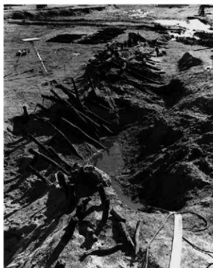
(2) 同 S-24区構築状況③ (北から)
