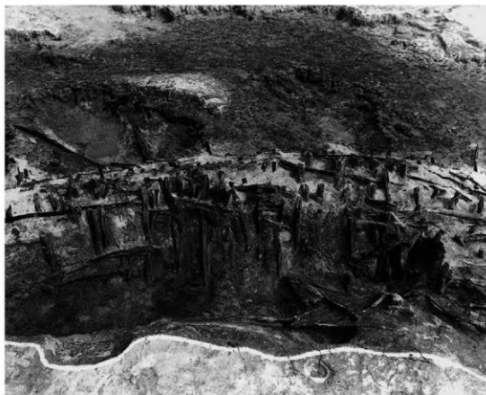
(1) SX395構築状況（西から）
