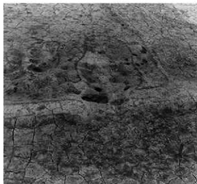
(6) SS349・350水口 (西から)
