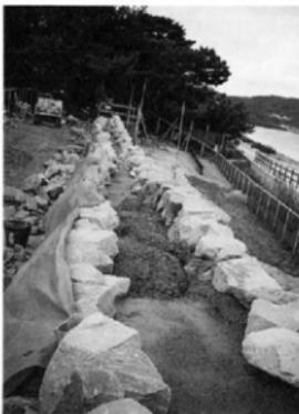
Ph.47 軽量コンクリート打設
