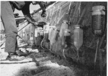
Ph.65 石積み下部砂地固化（点滴注入）
