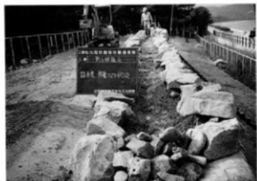
Ph.69 復元石積み内部の軽量コンクリート打設
