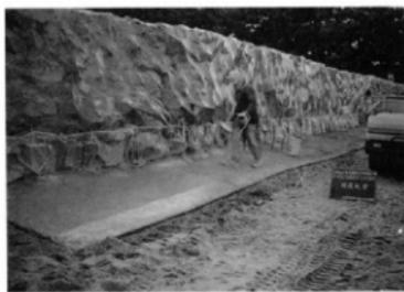
Ph.74 既存コンクリートに砂状舗装材を固着
