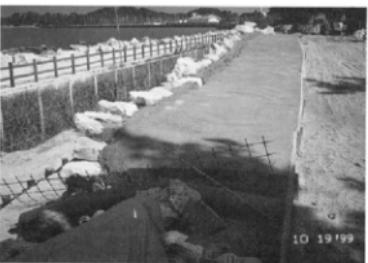
Ph.67 遺存石積み天端保護(発泡コンクリート打設)
