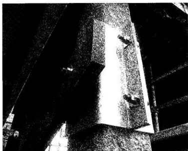
写真65 クラック箇所補強用ステンレス板 施工状況
