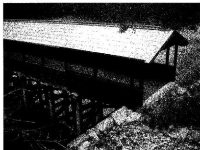
写真71 竣工櫓橋西面
