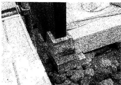
写真5-6 柱礎石（再用材）施工状況
