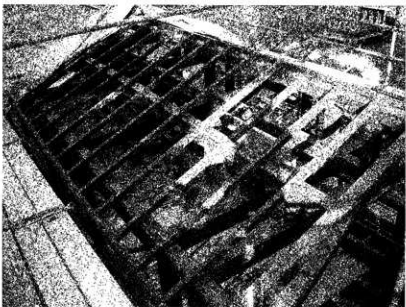
写真45 母屋・垂木施工状況
