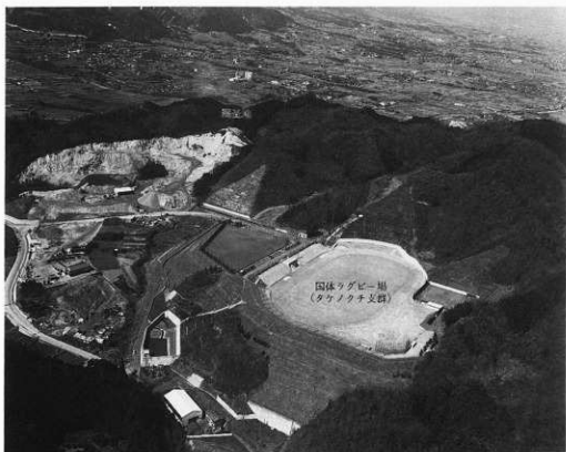
2. 第二次調査地 航空写真(東から)
