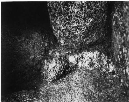
1. 巨勢山323号墳 奥室東側石下方漆喰陥入状況（南から）
