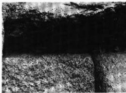
石構部外面 北側小口(天井石・奥壁・左側石と漆喰)
