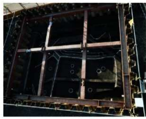
写真2-2-7 99Ac区1面 全景 (北東より)
