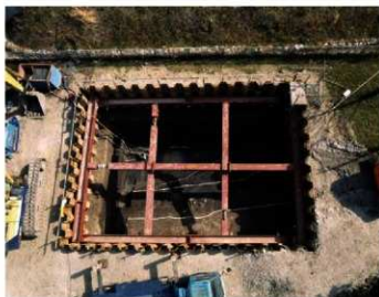
写真2-2-20 99Ae区1面全景
