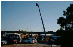
写真1-2-6 高所作業車による写真撮影
