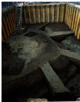
写真2-2-57 02Af区1面全景（南より）
