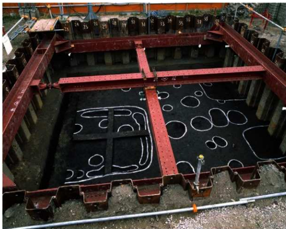
写真2-2-50 99Ad区1面全景（北より、8期の遺構群）
