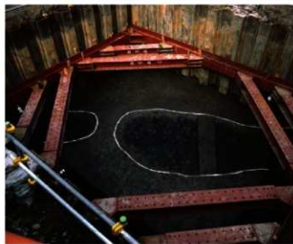
写真2-2-141 98Ca区SD01・SD02（南東より）
