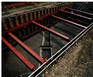
写真2-2-138 99Ce区SD02（南東より）
