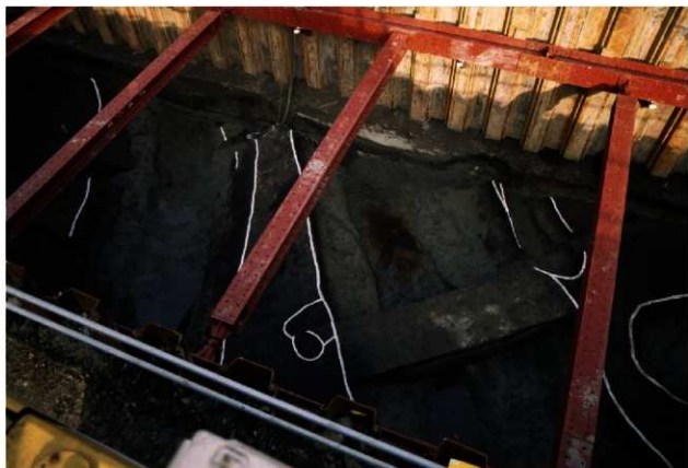
写真2-2-136 99Ce区SD07・SD08 (西より)
