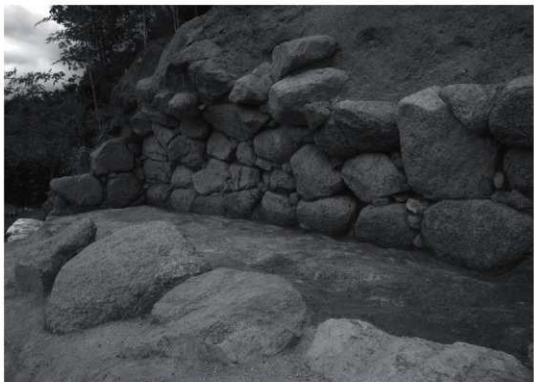
横穴式石室 左側壁（西から）
