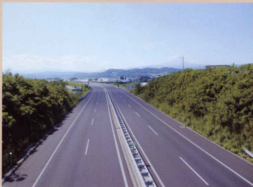
東北横断自動車道酒田線（寒河江市 高瀬山古墳橋より）
