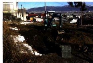
重機による埋め戻しの様子 (南から)
