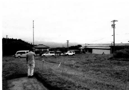
委託測量状況
