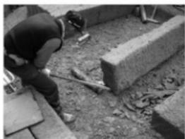
写真 67 石作り工程⑩・石の移動配置
