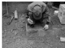
写真3 溝掘り工程①・線引き
