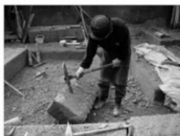
写真 86 身体動作・ツル削り（力才加工）-3
