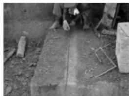
写真5 溝掘り工程③・線引き
