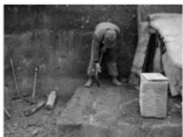
写真4 溝掘り工程②・溝ツキ
