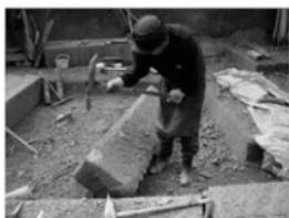
写真 85 身体動作・ツル削り（力才加工）-2
