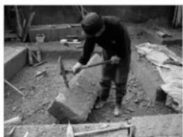
写真 84 身体動作・ツル削り（力才加工）-1
