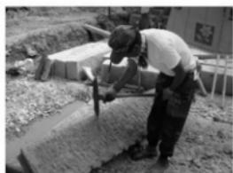
写真 24 石作り工程㉗・ツル削り
