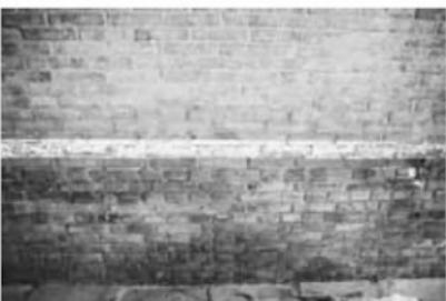
写真6 内部。側壁とアーチで煉瓦積みかたが違う (2005/1)
